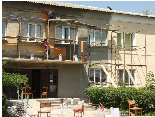
Ремонт в Арцизькій бібліотеці
